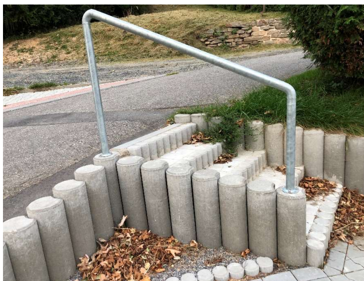
Vzorové ukotvení zábradlí do palisád
