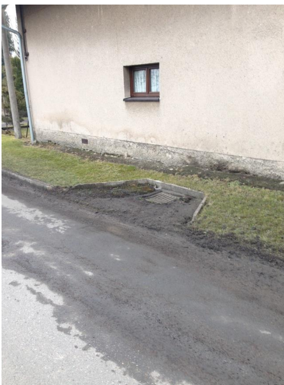
Obr. 3 Stávající uliční vpust' km 0,245
