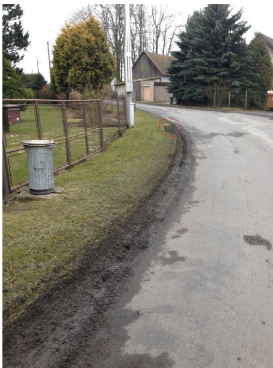
Obr. 4 Kamenný sloupek v krajnici km 0,215 Pohled proti směru staničení
