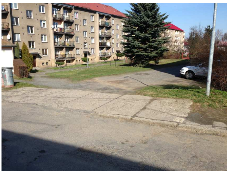
Obr. 4 Ulice Družstevní, Vjezd přes chodník na parkoviště bytového domu
