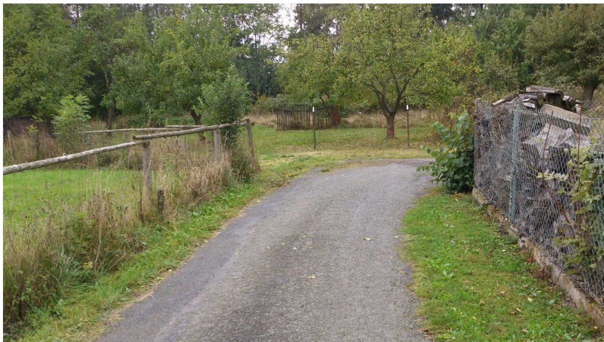
Větev „B“ v přechodu mezi stavebními oddíly SO02 a SO05
