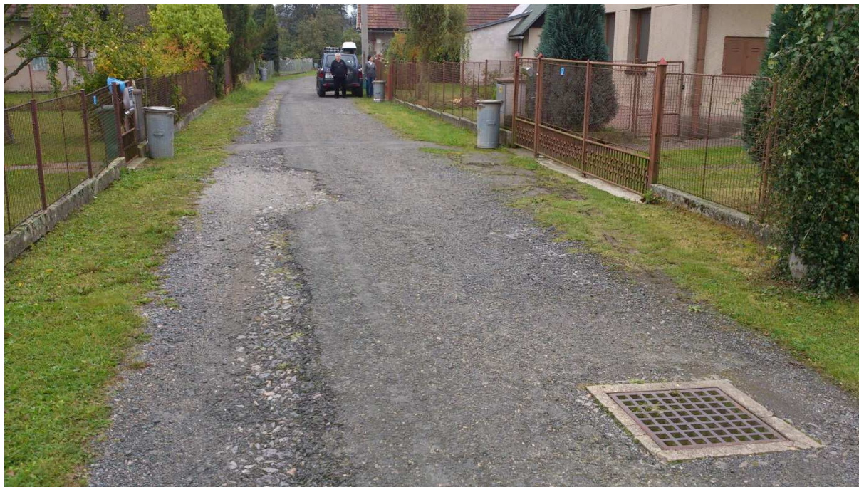
Větev „B“ pohled od RD č.p. 28 dále po staničení
