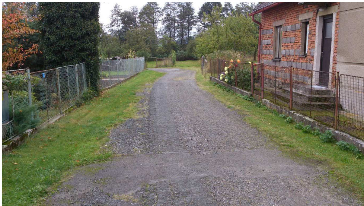
Větev „B“ pohled od RD č.p. 32 dále po staničení
